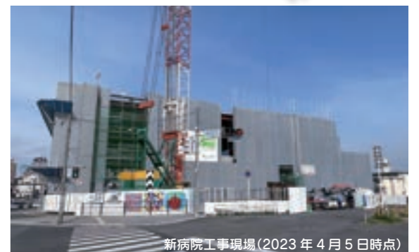
新病院工事現場(2023年4月5日時点)
